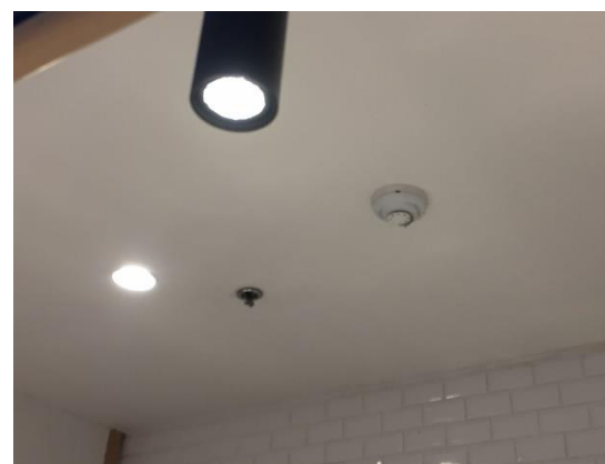
รูปที่ 33 อุปกรณ์ตรวจจับควัน
